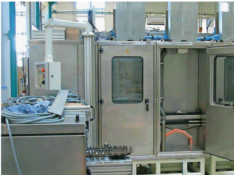
Wärmekammer im Bau
